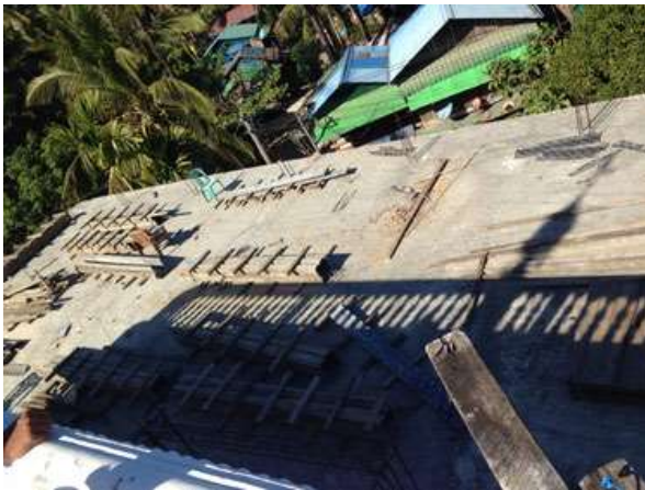
(写真上) タンドゥエ寺院学校、建築中の校舎の2階部分
